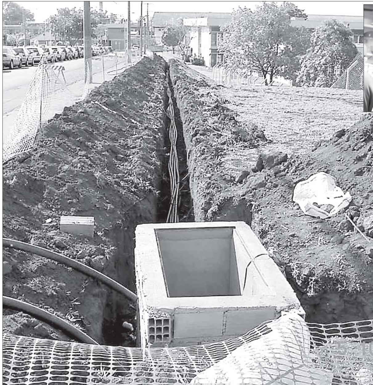
Obras no campus da Unicamp: advento da Internet baseada em sua própria fibra óptica
